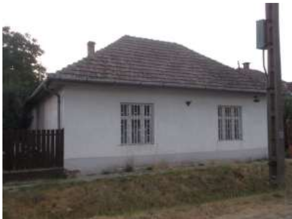
Az épület homlokzata
